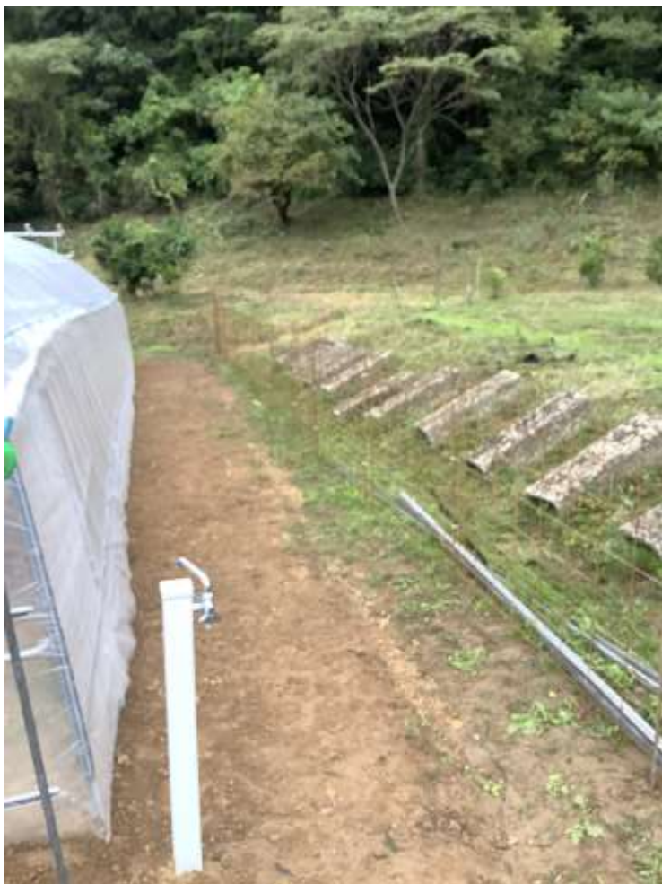
ハウス周辺の鉄柵の設置
