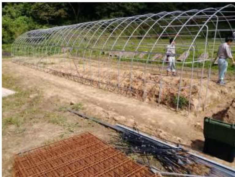
水道施設の整備
