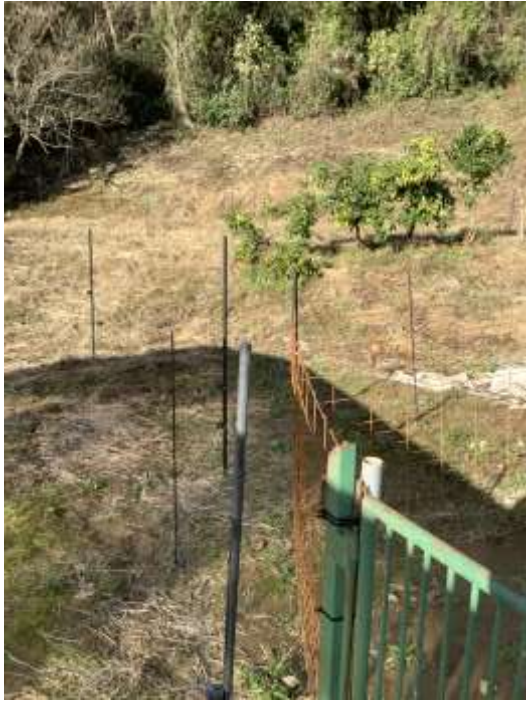
電気柵の設置
