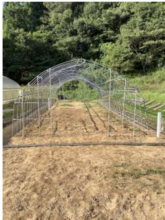
枠組みの完成
