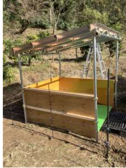
たい肥舎の設置
