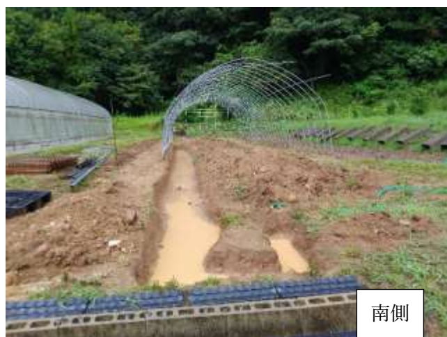
図3-1 ハウス養豚・基礎工事
